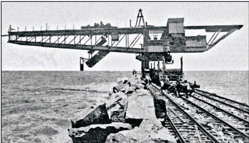
Fig. 1-2. Construção dos molhes da Barra do Rio Grande, entre 1911-15.
